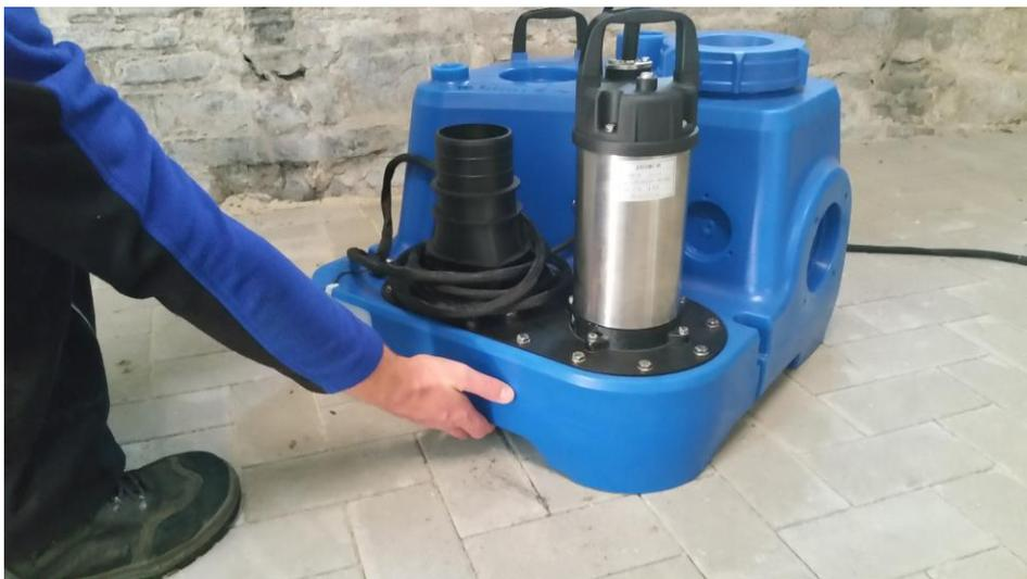
Schritt 4: Ausnivellieren der Anlage
