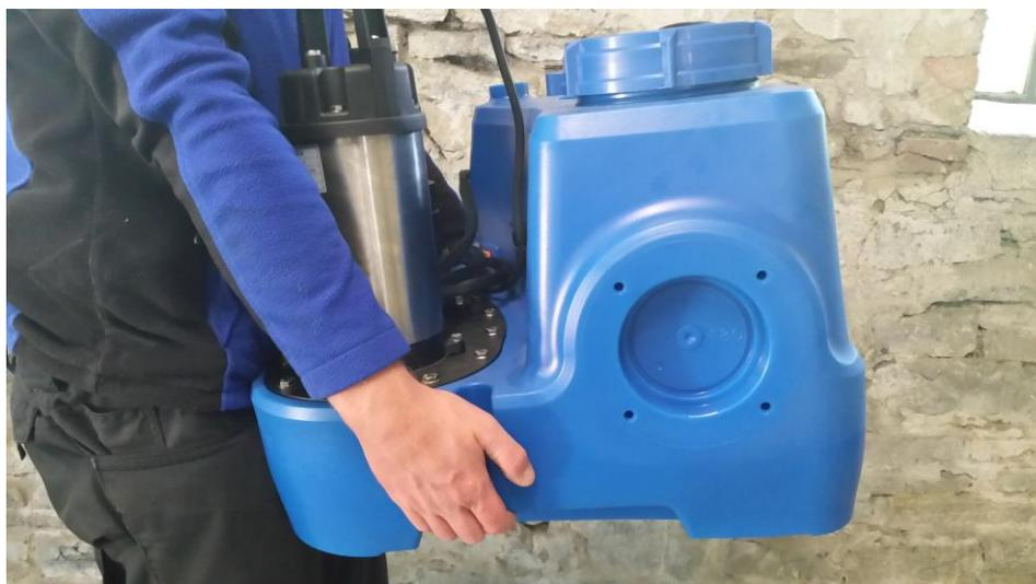
Schritt 2: Anlage in Montageöffnung einheben
